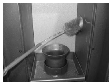
Fig. 28 - Limpieza con escobilla
