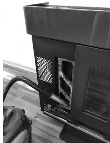
Fig. 33 - Limpieza camara de humos
