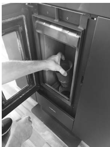
Fig. 23 - Extracción del brasero
