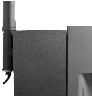
Fig. 34 - Limpieza canal de humos
