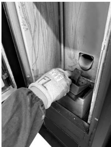
Fig. 27 - Rimozione braciere
