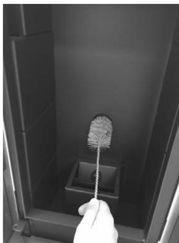
Fig. 30 - Nettoyage avec nettoie-pipes
