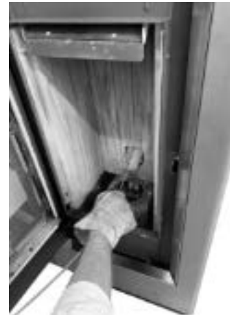
Fig. 36 - Limpieza con escobilla
