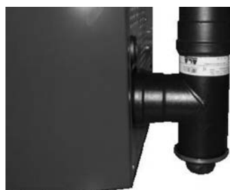
Fig. 28 - Reinigung des Rauchgaskanals
