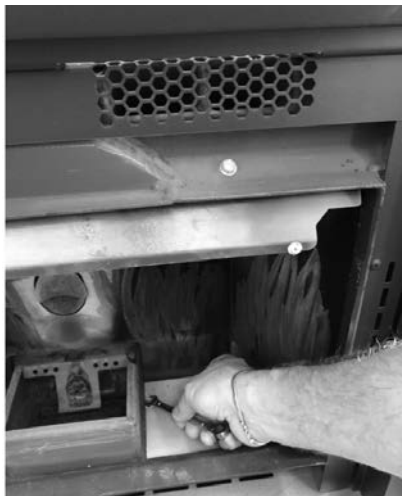
Fig. 33 - Retirer les vis
