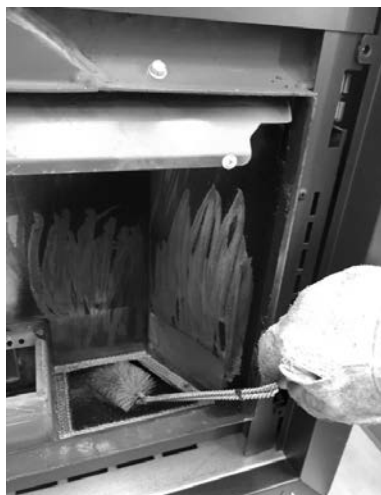
Fig. 35 - Nettoyer avec un goupillon.
