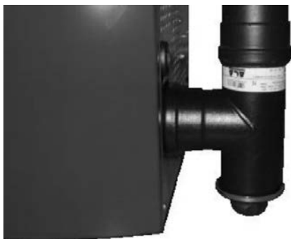
Fig. 24 - Limpieza canal de humos
