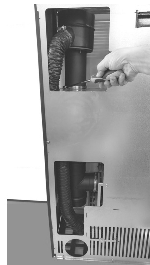
Fig. 35 - Bloccare con fascetta
