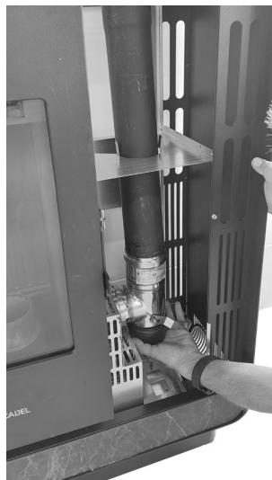
Fig. 53 - Pulizia canale da fumo
