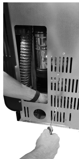
Fig. 37 - Collegare tubo flessibile
