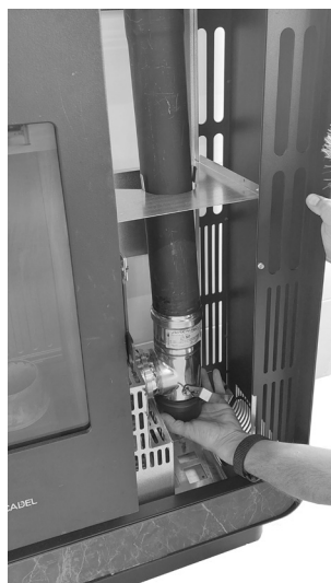
Fig. 62 - Nettoyage du conduit de fumée
