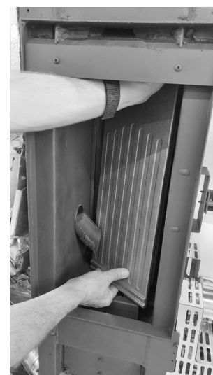
Fig. 65 - Retirer l'arrière du foyer 2
