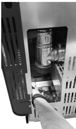
Fig. 45 - Insérez le tuyau flexible
