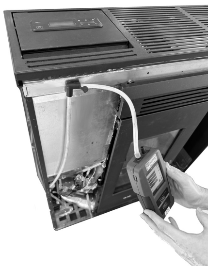
Fig. 48 - Conexión del presostato digital
