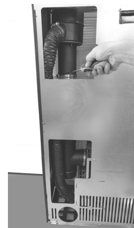
Fig. 38 - Bloqueo con abrazadera
